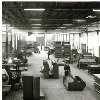
Bau des Werks am Sorøvej
